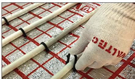
Рис. 2.7.4. Установка гарпунных скоб вручную
