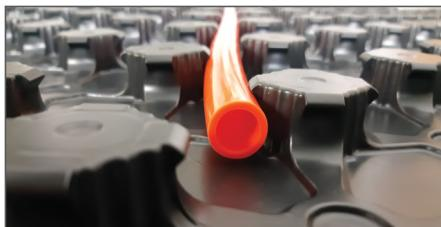
Рис. 2.7.1. Крепление труб между «бобышками» теплоизоляционных плит
