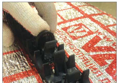
Рис. 2.7.7. Крепление шины гарпунной скобой к теплоизоляции
