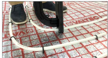
Рис. 2.7.5. Крепление труб скобами с помощью такера
