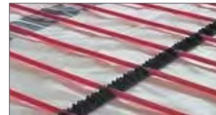
**Рис. 2.7.6.** Крепление труб тёплого пола с помощью шин-фиксаторов
