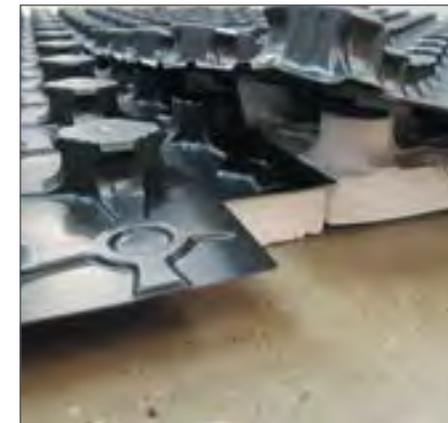
**Рис. 2.6.1. «Замковое» соединение плит «Экопол 20»**
