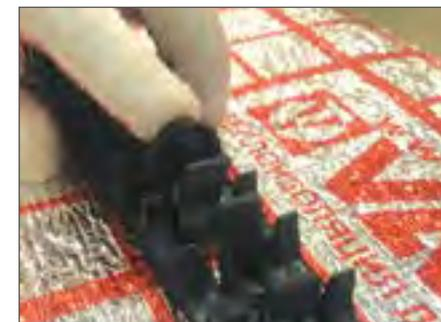
**Рис. 2.7.7.** Крепление шины гарпунной скобой к теплоизоляции
