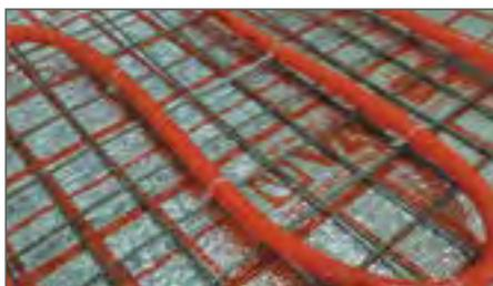
**Рис. 2.7.2.** Крепление труб стяжными хомутиками к сетке
