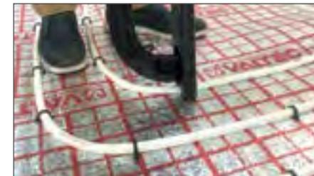
**Рис. 2.7.5.** Крепление труб скобами с помощью такера VT.T.01
