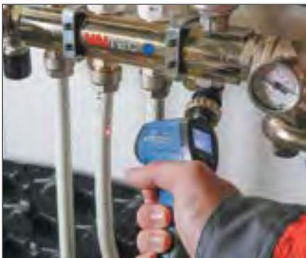
**Рис. 4.1.5.** Измерение температуры труб пирометром
