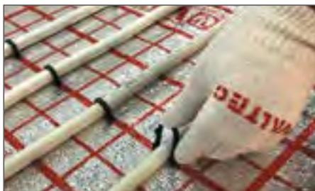
**Рис. 2.7.4.** Установка гарпунных скоб вручную
