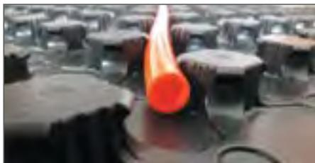
**Рис. 2.7.1.** Крепление труб между «бобышек» теплоизоляционных плит
