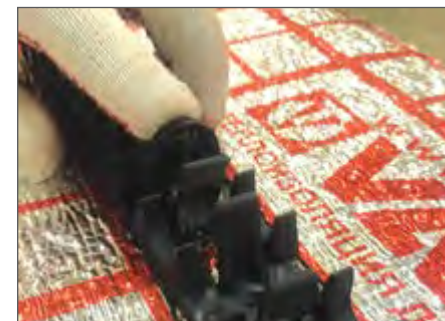
Рис. 2.7.7. Крепление шины гарпунной скобой к теплоизоляции
