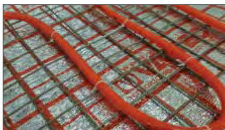
Рис. 2.7.2. Крепление труб стяжными хомутами к сетке
