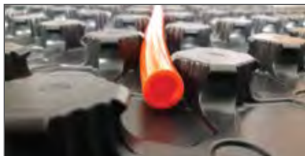
Рис. 2.7.1. Крепление труб между «бобышек» теплоизоляционных плит
