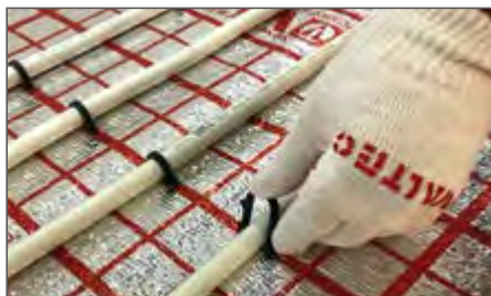
Рис. 2.7.4. Установка гарпунных скоб вручную
