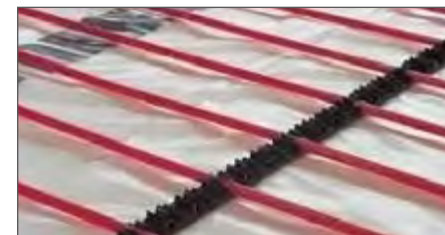
Рис. 2.7.6. Крепление труб тёплого пола с помощью шин-фиксаторов
