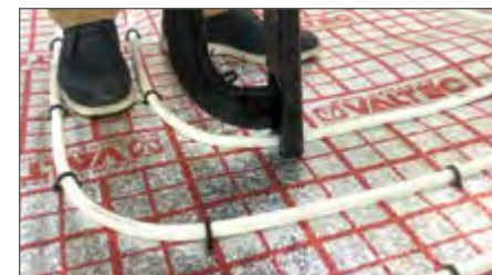
Рис. 2.7.5. Крепление труб скобами с помощью такера
