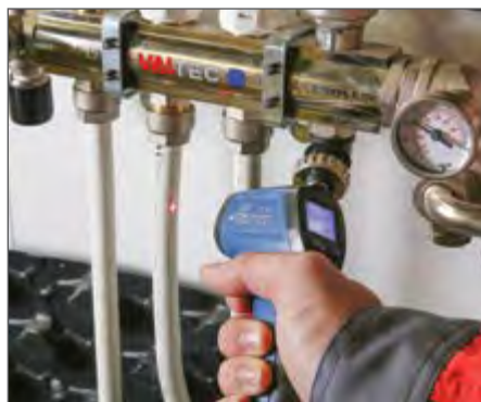
Рис. 4.1.5. Измерение температуры труб пирометром
