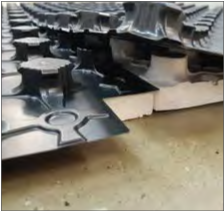
Рис. 2.6.1. «Замковое» соединение плит «Экопол 20»
