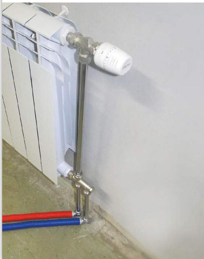
Рис. 4 Традиционное подключение радиатора
