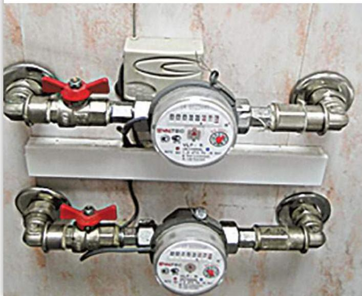
На трубах подачи воды в каждой квартире установлены водосчетчики с импульсным выходом. Радиопреобразователь импульсов VT.D100 устанавливается рядом (рис. 3) с приборами учета, и подключается к ним напрямую. К одному VT.D100 можно подключить два счетчика (рис. 2).
