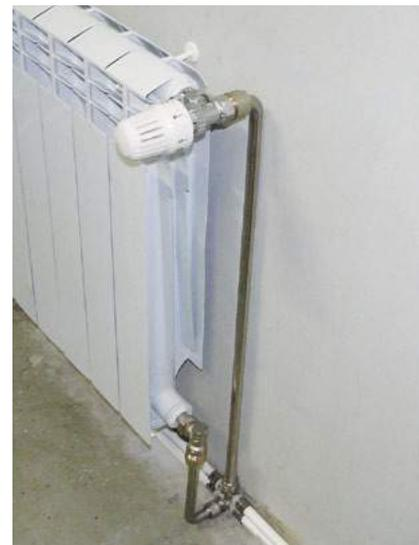
Рис. 18 Термостатический клапан с преднастройкой VT.037
