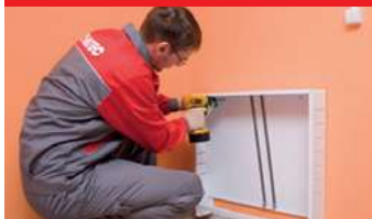
1. Монтаж коллекторного шкафа
