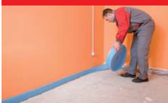
6. Укладка утеплителя (пенополистирол с покрытием)
