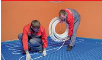
7. Укладка петель теплого пола (металлополимерная труба VALTEC)
