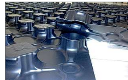
Рис. 33. Укладка плит внахлест с фиксацией края плит
