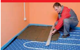
10. Заливка бетонной стяжки с пластификатором
