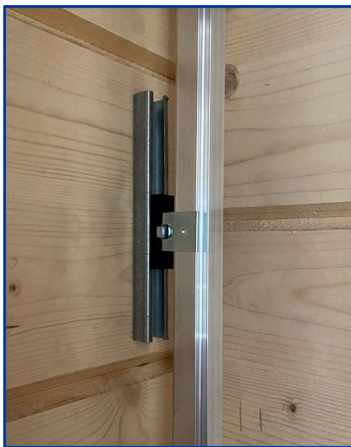
Пример установки скользящих опор WB90123 на объекте
