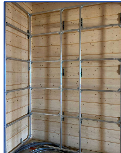
Пример установки скользящих опор WB90123 на объекте
