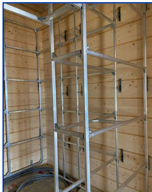
Пример установки скользящих опор WB90123 на объекте
