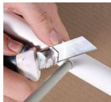
4.2.6. Через две минуты излишки ремонтного стержня обрезаются ножом.
