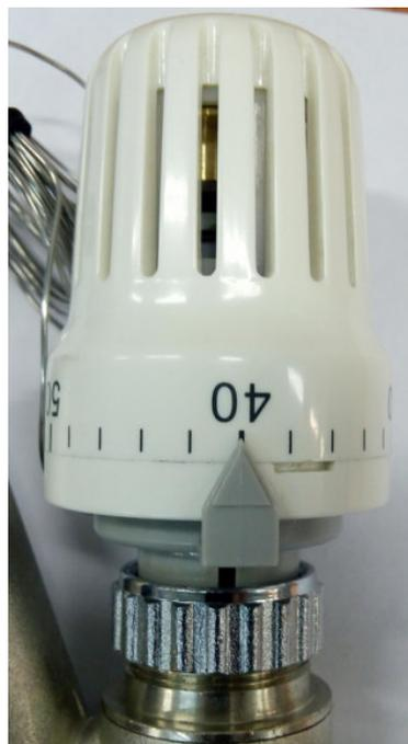
6.4. При промывке стояка рециркуляции необходимо выставить термоэлемент клапана в максимальное положение (дополнительная риска после 60 °С)
