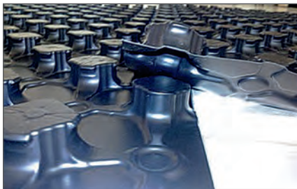
Рис. 32. Укладка плит внахлест с фиксацией края плит
