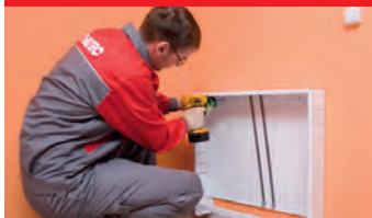
1. Монтаж коллекторного шкафа
