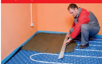
10. Заливка бетонной стяжки с пластификатором
