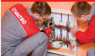
2. Установка в шкафу насосно-смесительного узла и коллекторного блока
