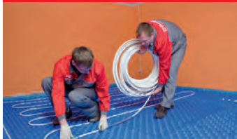
7. Укладка петель теплого пола (металлополимерная труба VALTEC)
