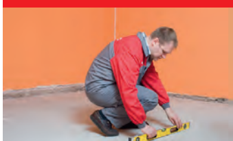
3. Подготовка поверхности пола
