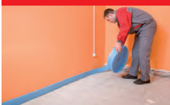
6. Укладка утеплителя (пенополистирол с покрытием)
