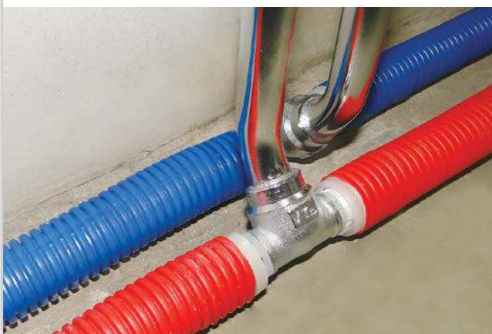
Подводить теплоноситель к радиаторам без перекрещивания трубопроводов позволяют специальные фитинги, такие, например, как тройник с хромированной трубкой VTm. 282 (см. рис. 8).
