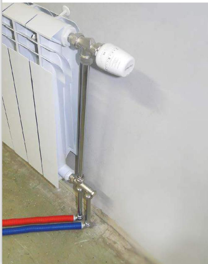
Рис. 4 Традиционное подключение радиатора
