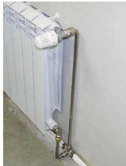
Рис. 18 Термостатический клапан с преднастройкой VT.037
