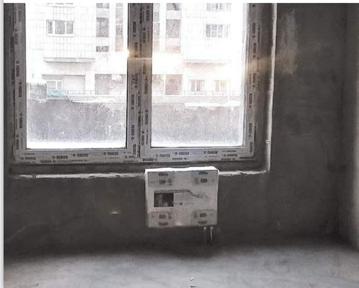
При подборе отопительных приборов в современных домах часто бывает ситуация, при которой длина выбранных отопительных приборов значительно меньше ширины оконного проёма (рис. 30).
