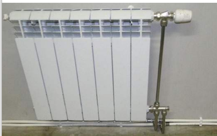
Рис. 14 Подключение прибора с помощью фитингов VTm.233.I и отвода VTi.960
