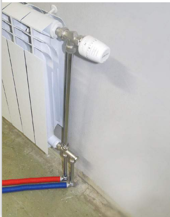
Рис. 3 Подключение радиатора с помощью угольника VTm.281
