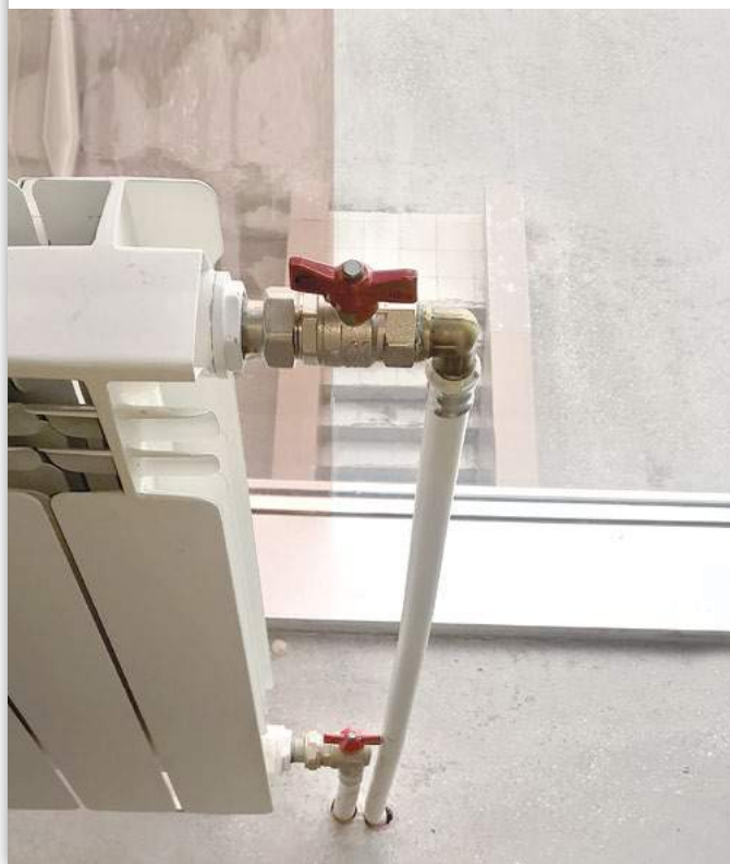
Рис. 4 Традиционное подключение радиатора
