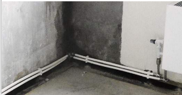
Рис. 10 Плинтусная прокладка трубопроводов
