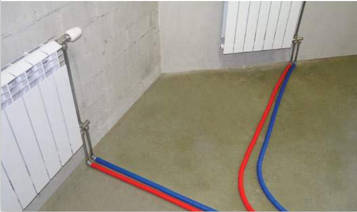
Рис. 20 Подключение радиаторов при коллекторно-лучевой схеме
