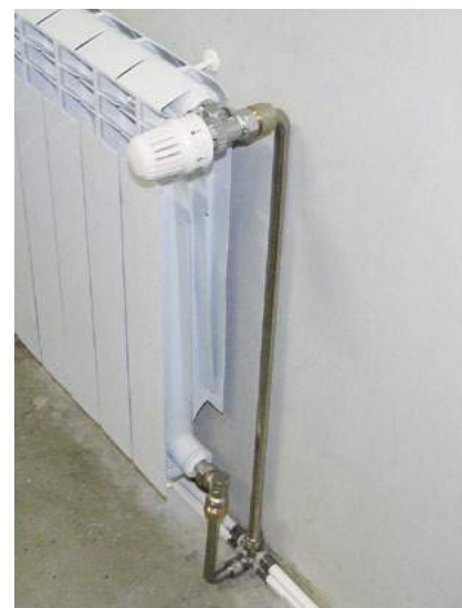
Рис. 17 Подключение радиатора с использованием комплекта VT.045
