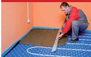
10. Заливка бетонной стяжки с пластификатором
