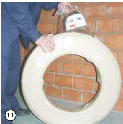
11 С бухты трубы снимаются полиэтиленовая упаковочная лента
