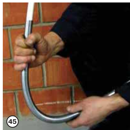
45 При протяженных отрезках неразрезной трубы следует использовать наружный кондуктор, который передвигается по трубе последовательно от одного изгибаемого участка к следующему
