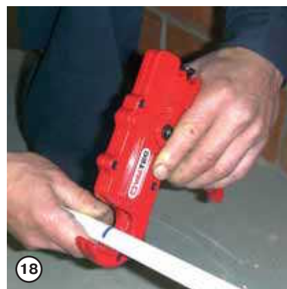
18 Отрезается требуемый кусок трубы. Это можно делать с помощью гильотинного трубореза в следующем порядке: –труба помещается в опорную скобу трубореза;
