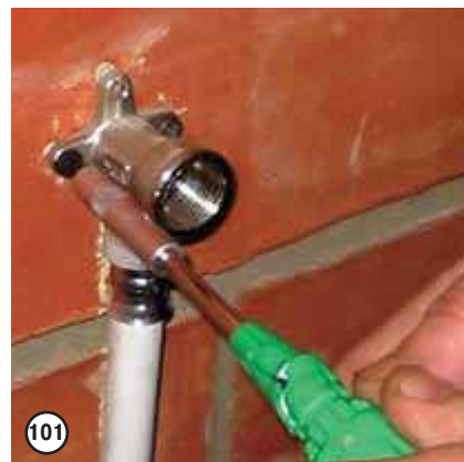
101 После выполнения всех соединений труба окончательно фиксируется на опорах, водорозетки крепятся к стене
