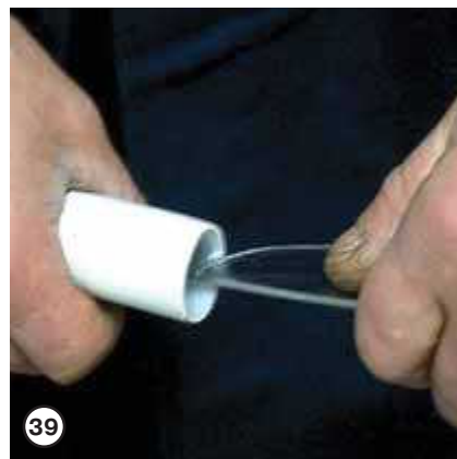
39 Можно снимать фаску с помощью ножа, но при этом нужно стараться, чтобы нож не врезался в материал, а скоблил его
