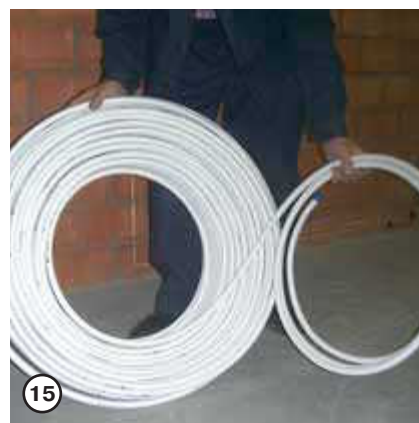
15 Отматывается необходимое количество трубы
