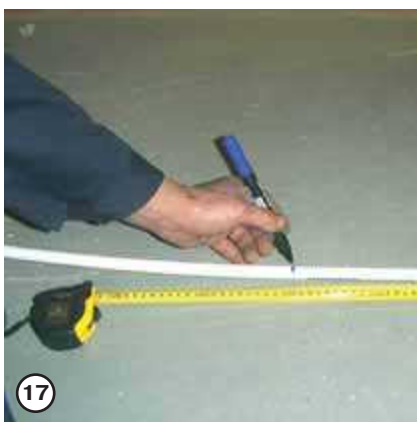
17 С помощью рулетки отмеряется точное количество трубы и делается метка фломастером
