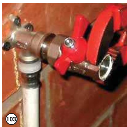
103 На одну из водорозеток, расположенных в верхней точке системы, устанавливается временный шаровый кран для выпуска воздуха
