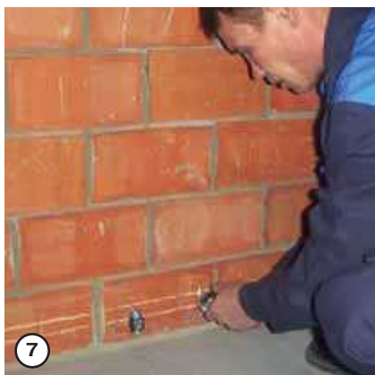
7 Устанавливаются неподвижные опоры
