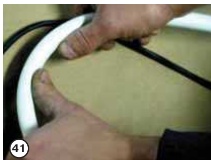
41 При наличии на трассе углов поворота, трубу требуется изогнуть, придав ей проектный радиус изгиба. Вручную можно изгибать трубы диаметром 16 и 20 мм, при этом радиус изгиба должен быть соответственно не менее 80 и 100 мм. Для обеспечения заданного радиуса удобнее использовать выполненный из мягкой проволоки шаблон
