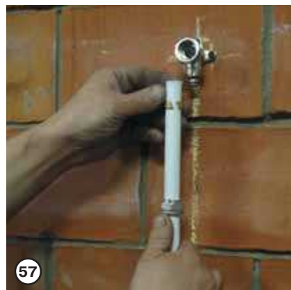
Затем на трубу надевается «сухарь»
