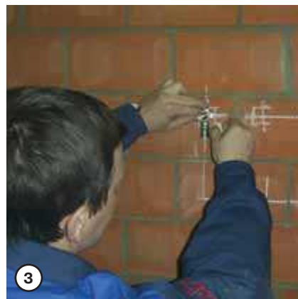
3 Намечаются места установки водорозеток
