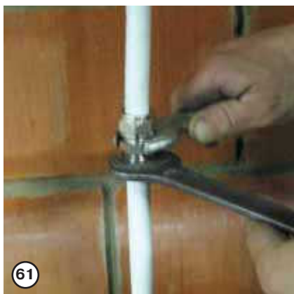
При этом фитинг придерживается за монтажные площадки вторым ключом
