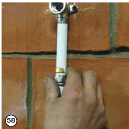
Немного покручивая трубу, ее одевают на штуцер фитинга
