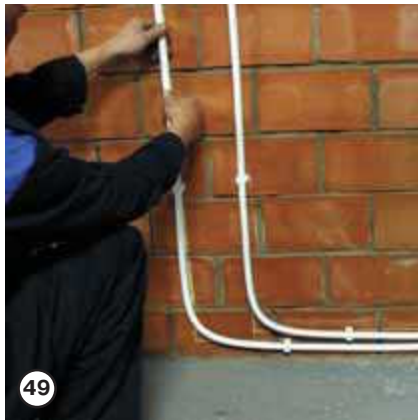
49 Трубная заготовка предварительно устанавливается в проектное положение (на подвижные опоры)
