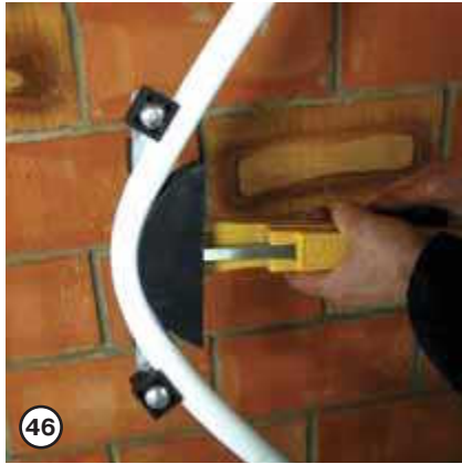
46 Для изгибания труб диаметром 32 мм и выше, используется реечный трубогиб, который значительно облегчает изгибание трубы с приданием ей радиуса изгиба 3Дн
