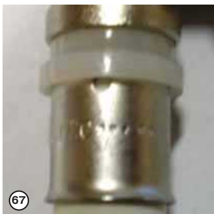
Труба надевается на штуцер до тех пор, пока ее не будет видно в круглом отверстии в основании составной гильзы
