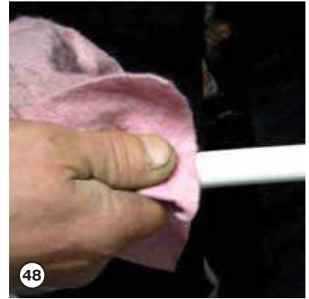
48 Если из эстетических соображений с металлопластиковой трубы необходимо удалить надписи, то это делается с помощью мыльного раствора и неабразивной ветоши
