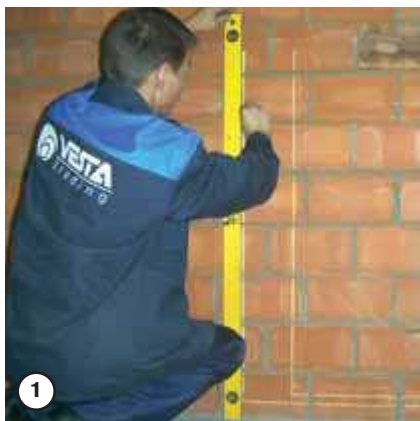
1 Разметка трассы трубопровода
