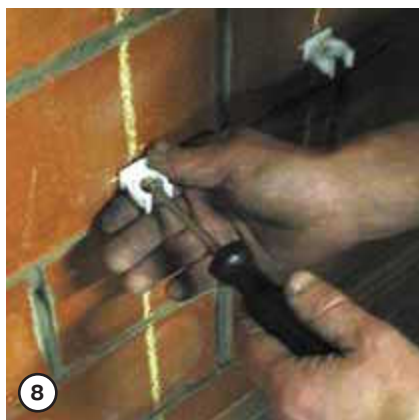
8 Устанавливаются подвижные опоры
