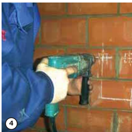
4 Высверливаются гнезда для крепления опор и водорозеток
