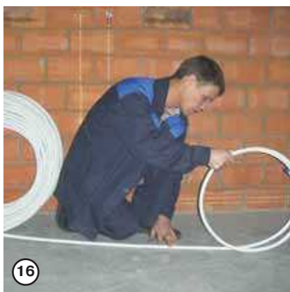
16 Вручную распрямляется отмотанный участок трубы
