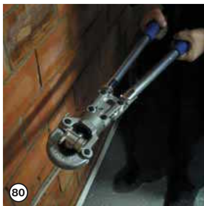
80 Производится опрессовка гильзы
