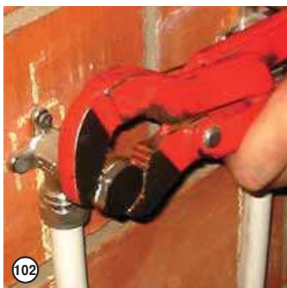
102 Затем производится гидравлическое испытание трубопровода, для чего все водорозетки глушатся временными резьбовыми пробками
