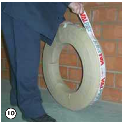
10 С упакованной бухты трубы снимается радиальный упаковочный скотч с логотипом фирмы-изготовителя
