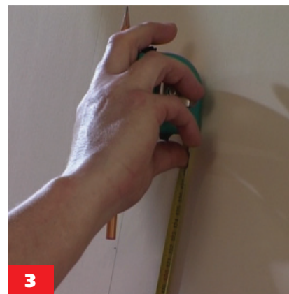
3 Намечаются места установки водорозеток
