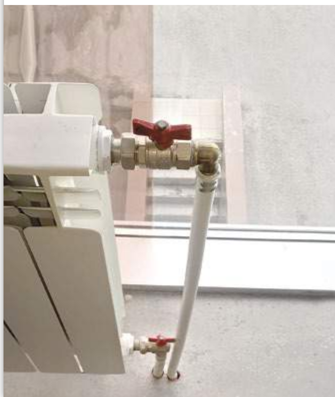
Рис. 4 Традиционное подключение радиатора
