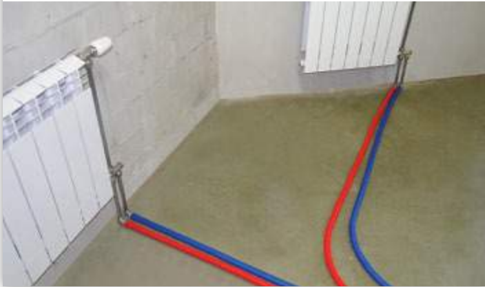
Рис. 20 Подключение радиаторов при коллекторно-лучевой схеме
