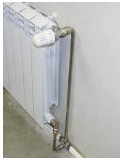
Рис. 17 Подключение радиатора с использованием комплекта VT.045
