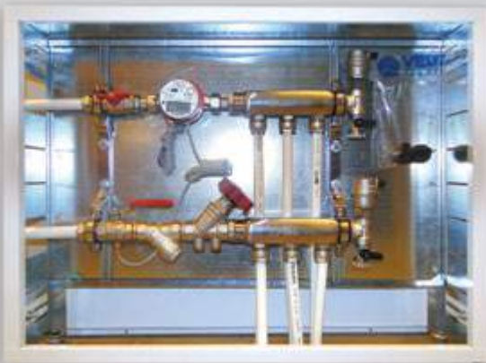
Рис. 21 Коллекторный шкаф с узлом учета тепловой энергии
