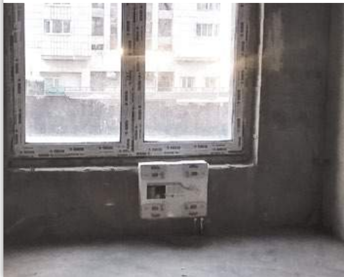
Рис. 30 Пример несоответствия длины прибора ширине проёма
