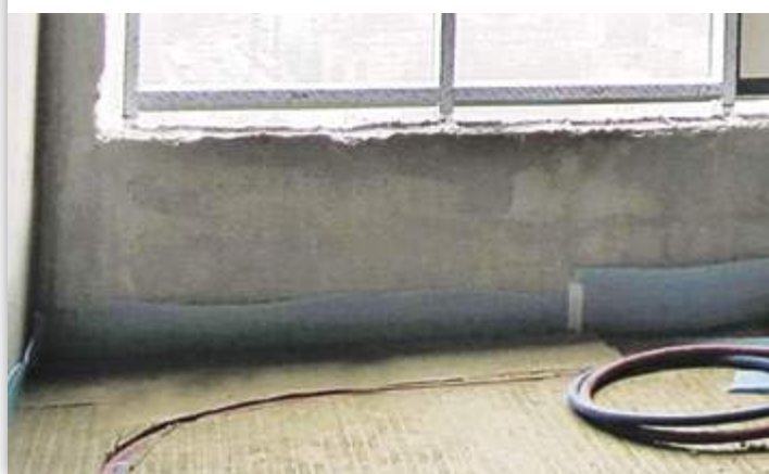
Рис. 6 Прокладка трубопроводов в штробах шумоизоляционных плит
