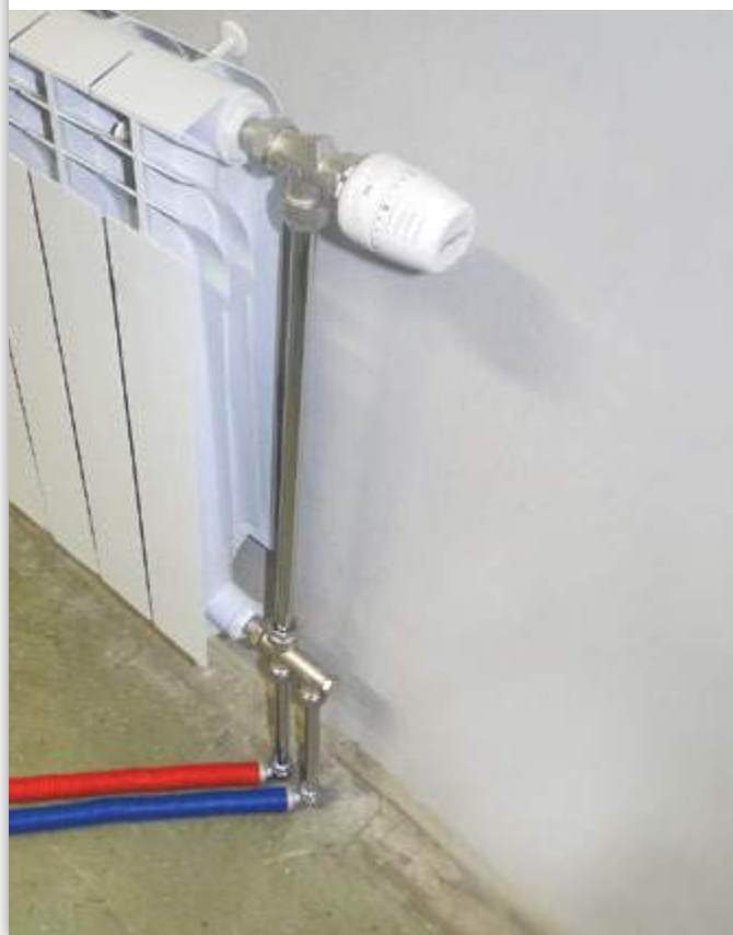
Рис. 3 Подключение радиатора с помощью угольника VTm.281
