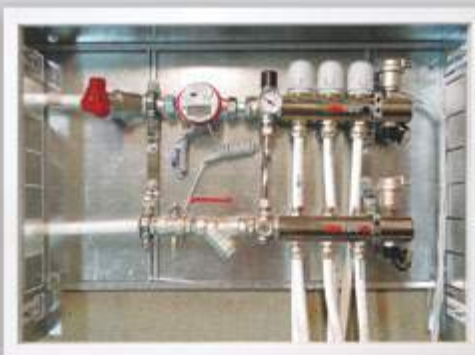
Рис. 25 Коллекторный узел с функцией терморегулирования
