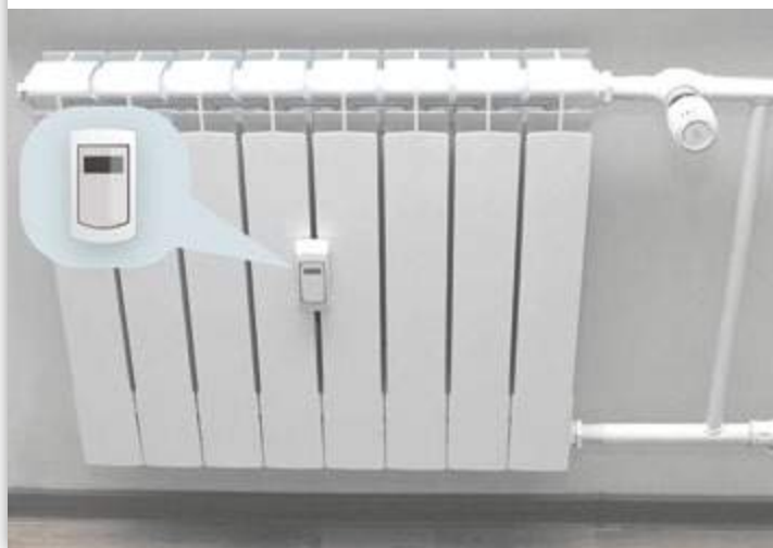
Рис. 5 Распределитель стоимости тепловой энергии
