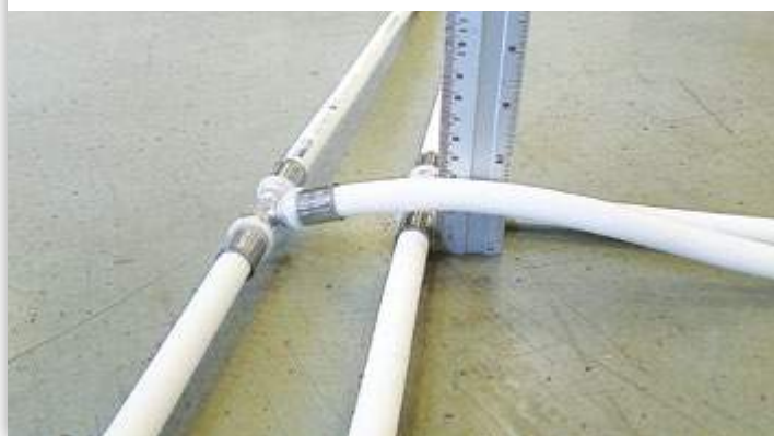
Рис. 5 Взаимное перекрещивание трубопроводов
