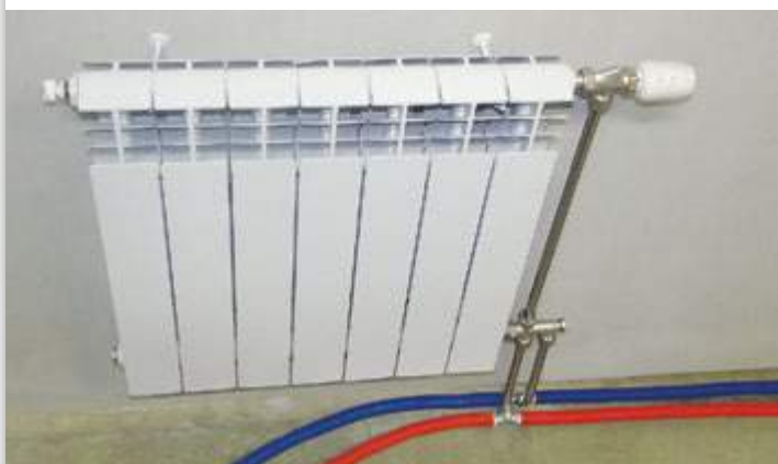
Рис. 8 Пример подключения радиатора с помощью фитинга VTm.282
