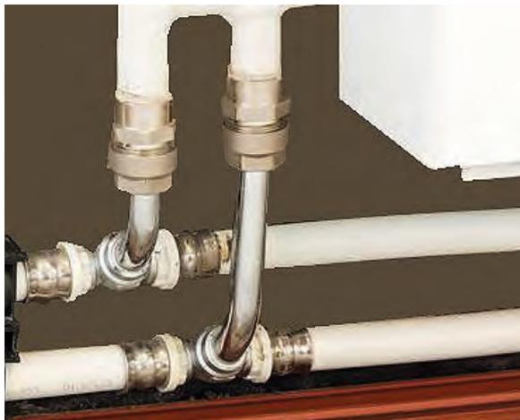
Квартирные тепловодомерные станции стали всё чаще использоваться в массовом жилищном строительстве. Наличие такой станции позволяет организовать единый, как правило, вынесенный за пределы квартиры узел учета и управления такими ресурсами, как вода и тепловая энергия. Установка квартирной станции подразумевает не вертикальную, а горизонтальную разводку трубопроводов отопления к отопительным приборам. Трубы могут под-
